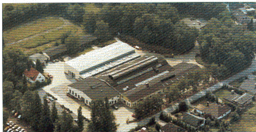
NEUHAUS Maschinen- und Anlagenbau GmbH, Ganderkesee 2,
