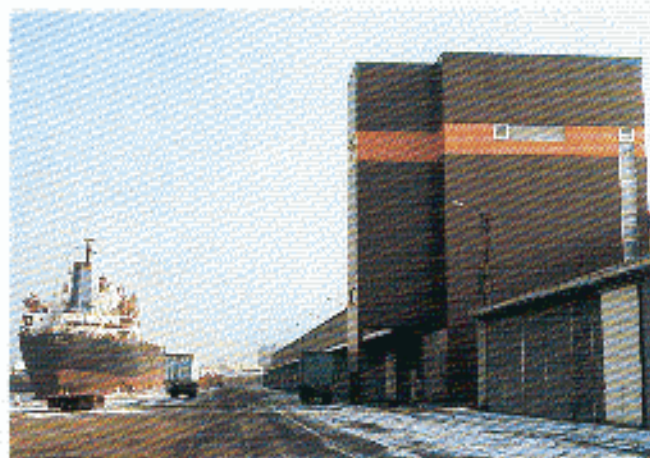
Rohkaffeestilo / Silo for Green Coffee Fassung / capacity 450 t (Le Havre)
